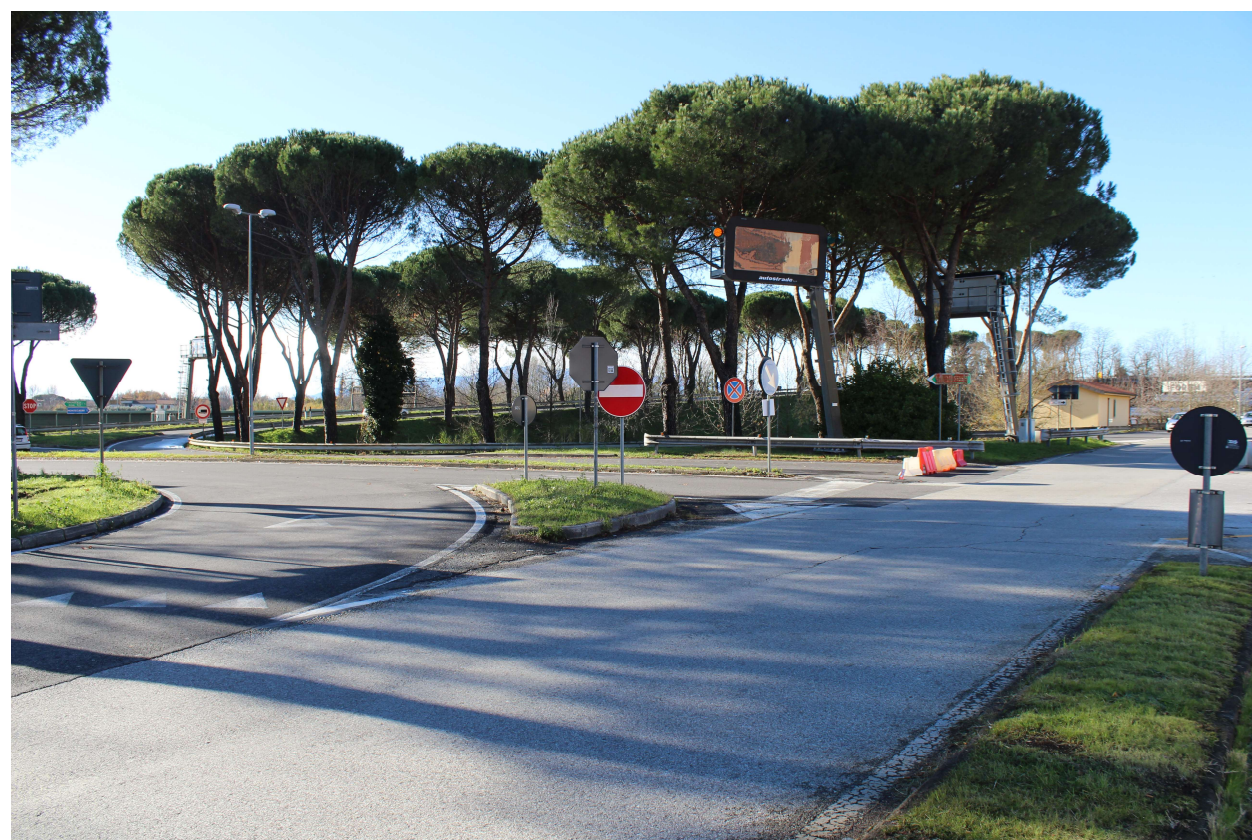
Figura 3.1.3.4 – vista dell'area di intervento da Viale Roma (direzione Montecatini Terme)
