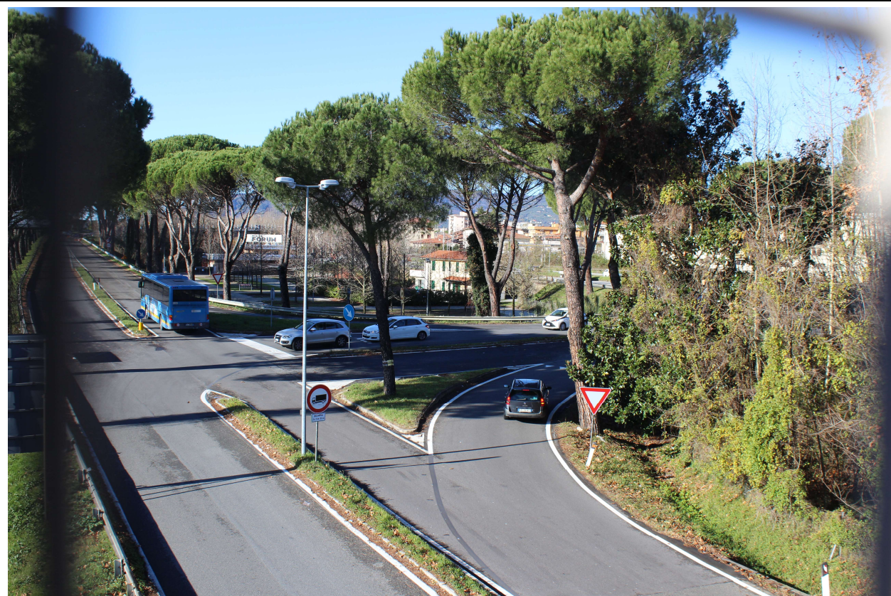
Figura 3.1.3.7 – vista dell'area di intervento da Via Marconi (cavalcavia autostradale)
