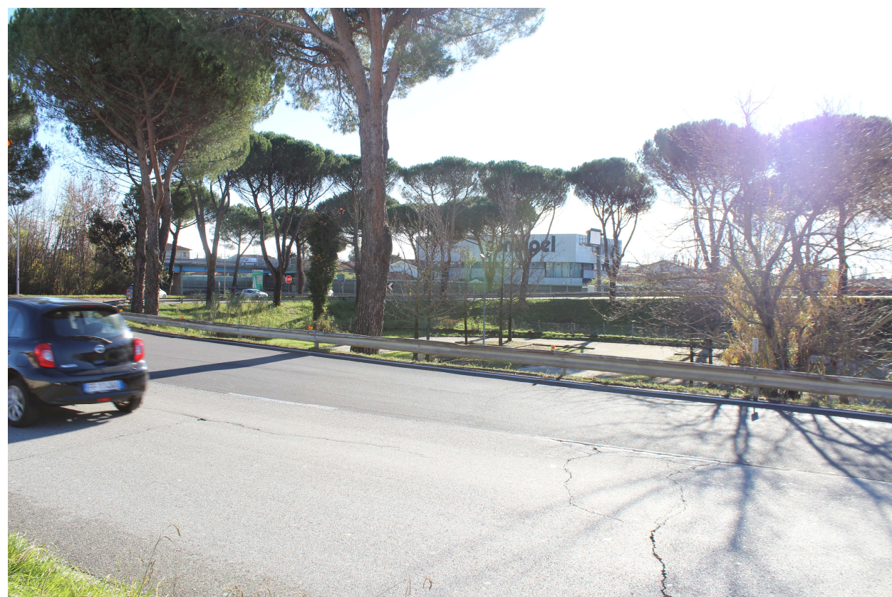
Figura 4.1.3.2 – area di cantiere vista da Viale Roma
