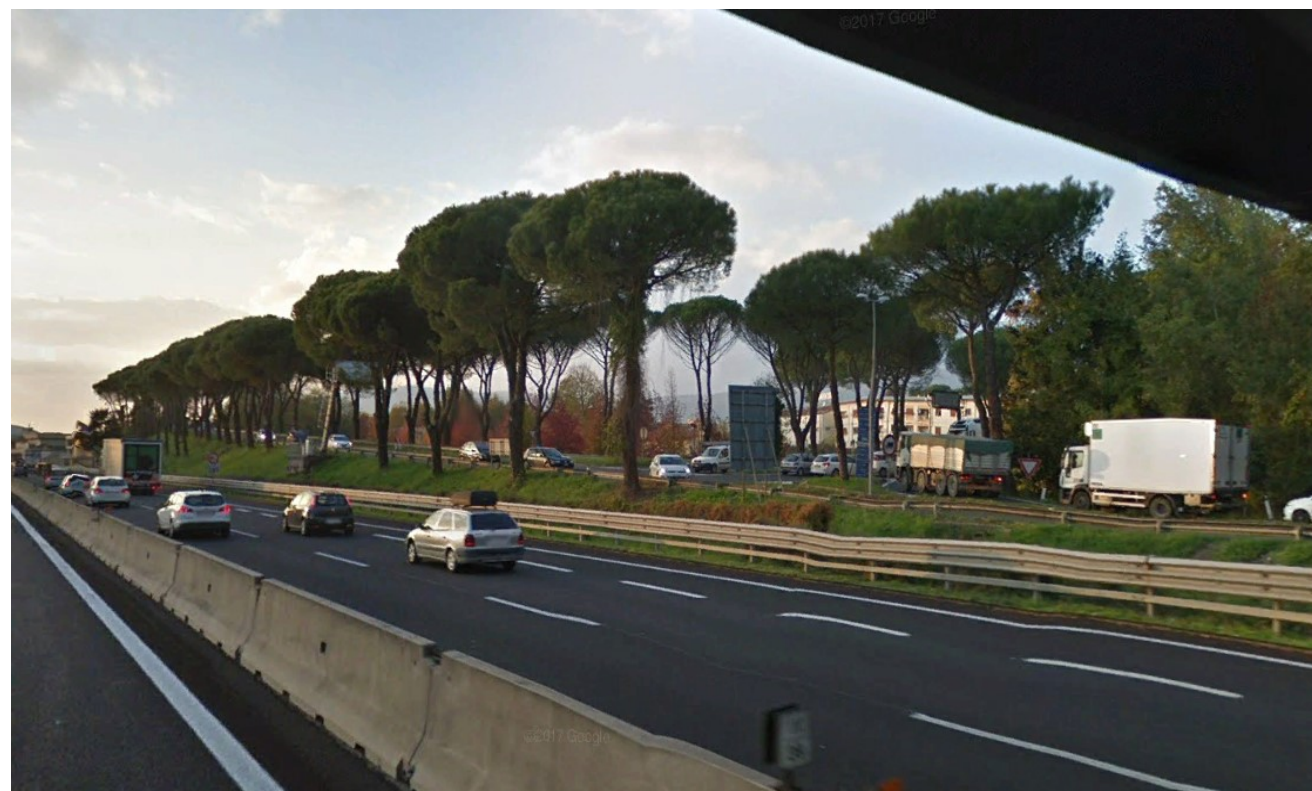
Figura 3.1.3.1 – vista dell'area di intervento dalla corsia direzione Firenze
